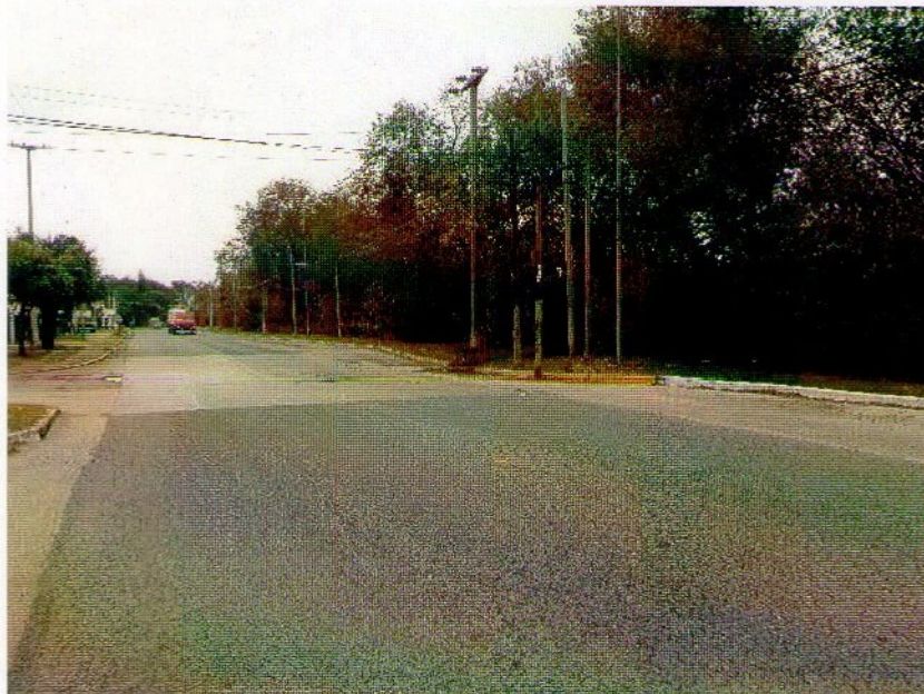
Figura 3: Badén 1 ubicado sobre la calle Italia al Oeste del loteo.
