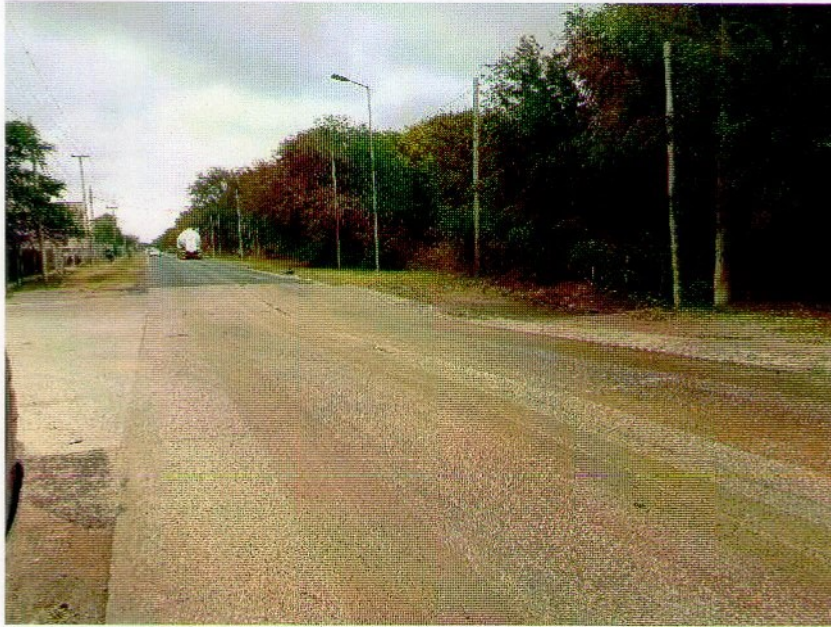
Figura 4: Badén 2 ubicado sobre la Calle Italia al Oeste del loteo.
